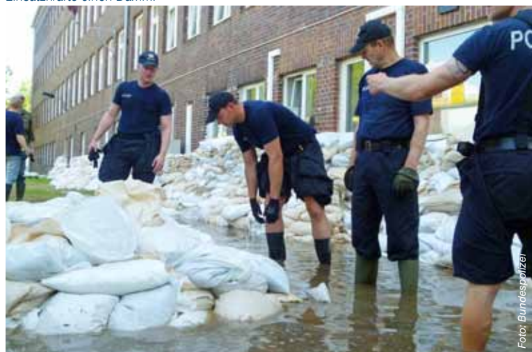
Mit Sandsäcken gegen die Wassermassen: Knetief im Wasser verstärken Einsatzkräfte einen Damm.
