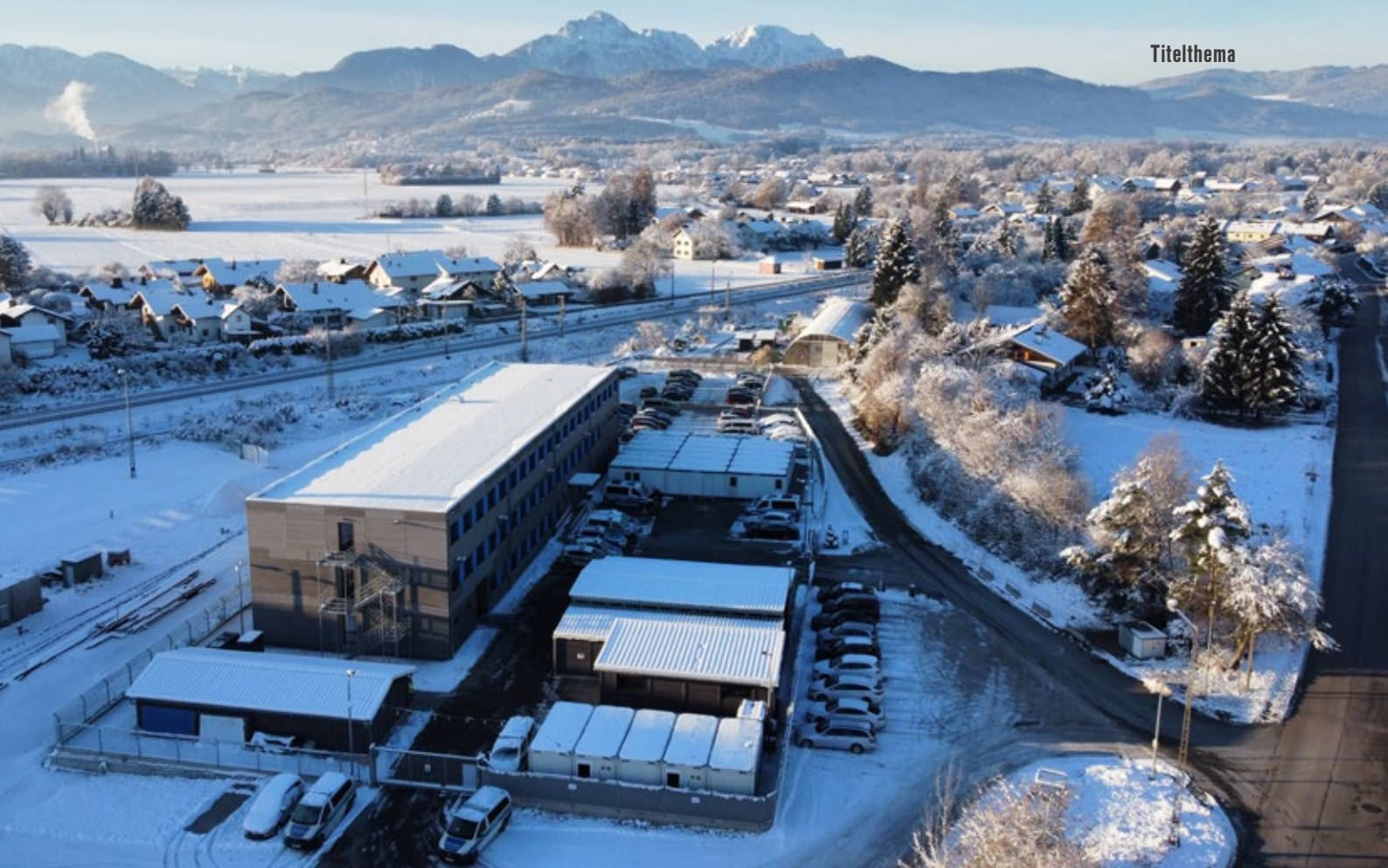
Die Liegenschaft der Bundespolizeiinspektion Freilassing im Winter
