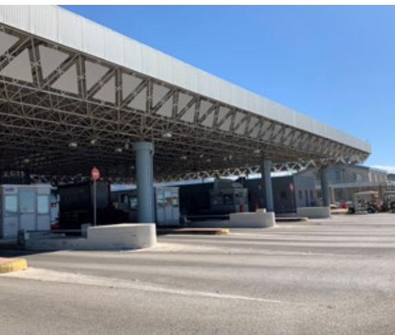
Kontrollstelle zur Einfahrt in den Fährhafen Patras (Griechenland)
