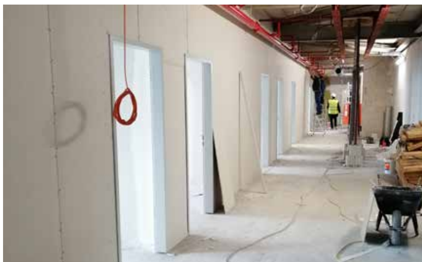
Es wurden neue Leitungen verlegt und die Raumaufteilung verändert.
