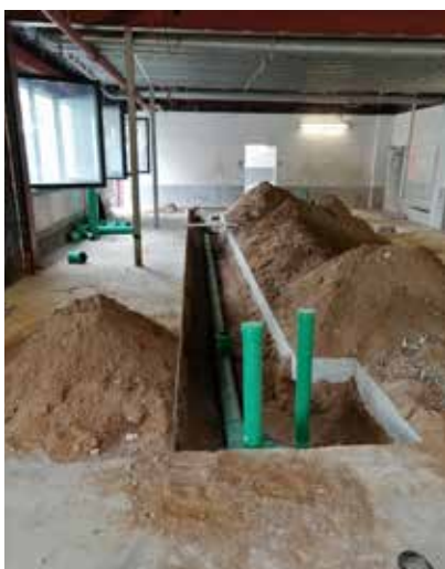
Während der Sanierung wurden umfangreiche Tiefbauarbeiten durchgeführt.
