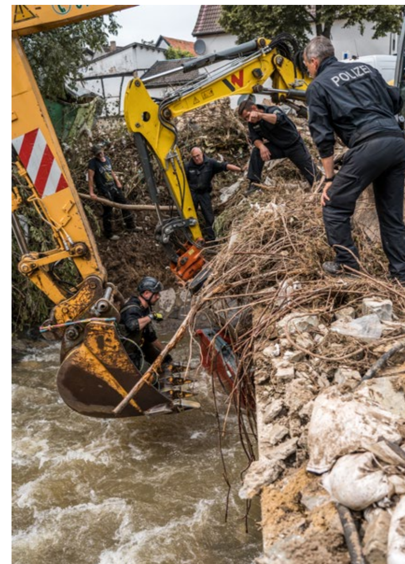
Mit schwerem Gerät werden Reste einer Brücke geräumt.
