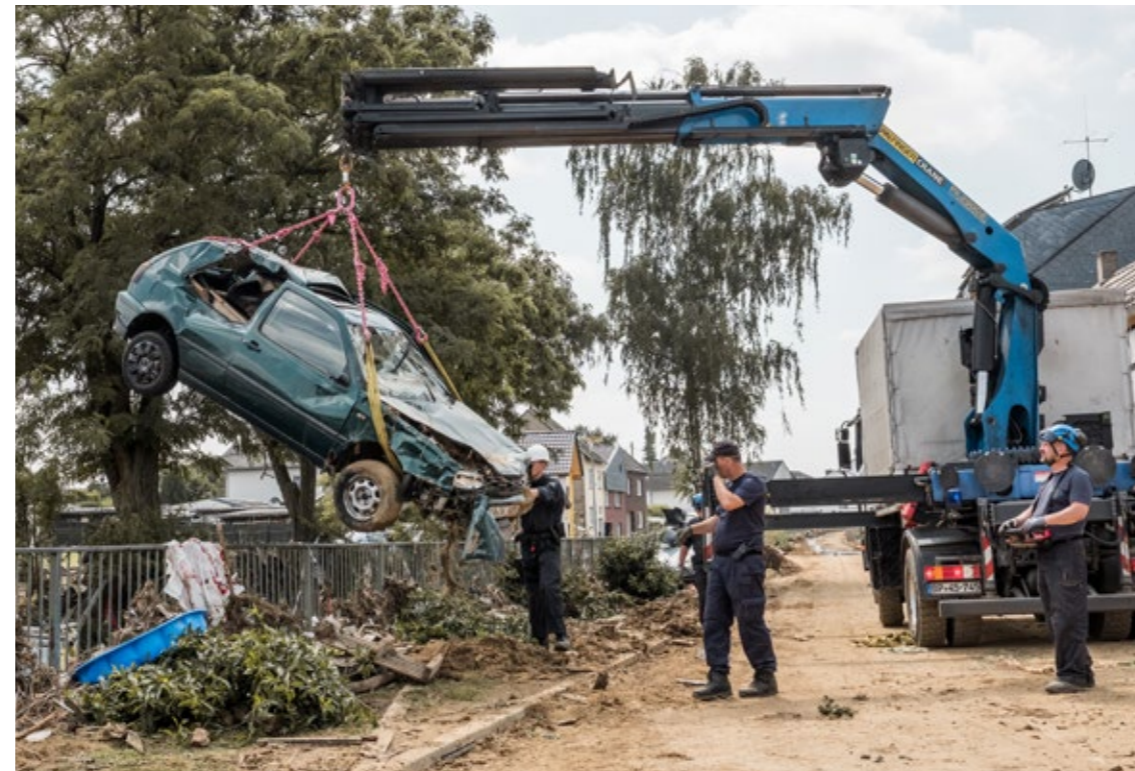
Einsatz von schwerem Gerät
