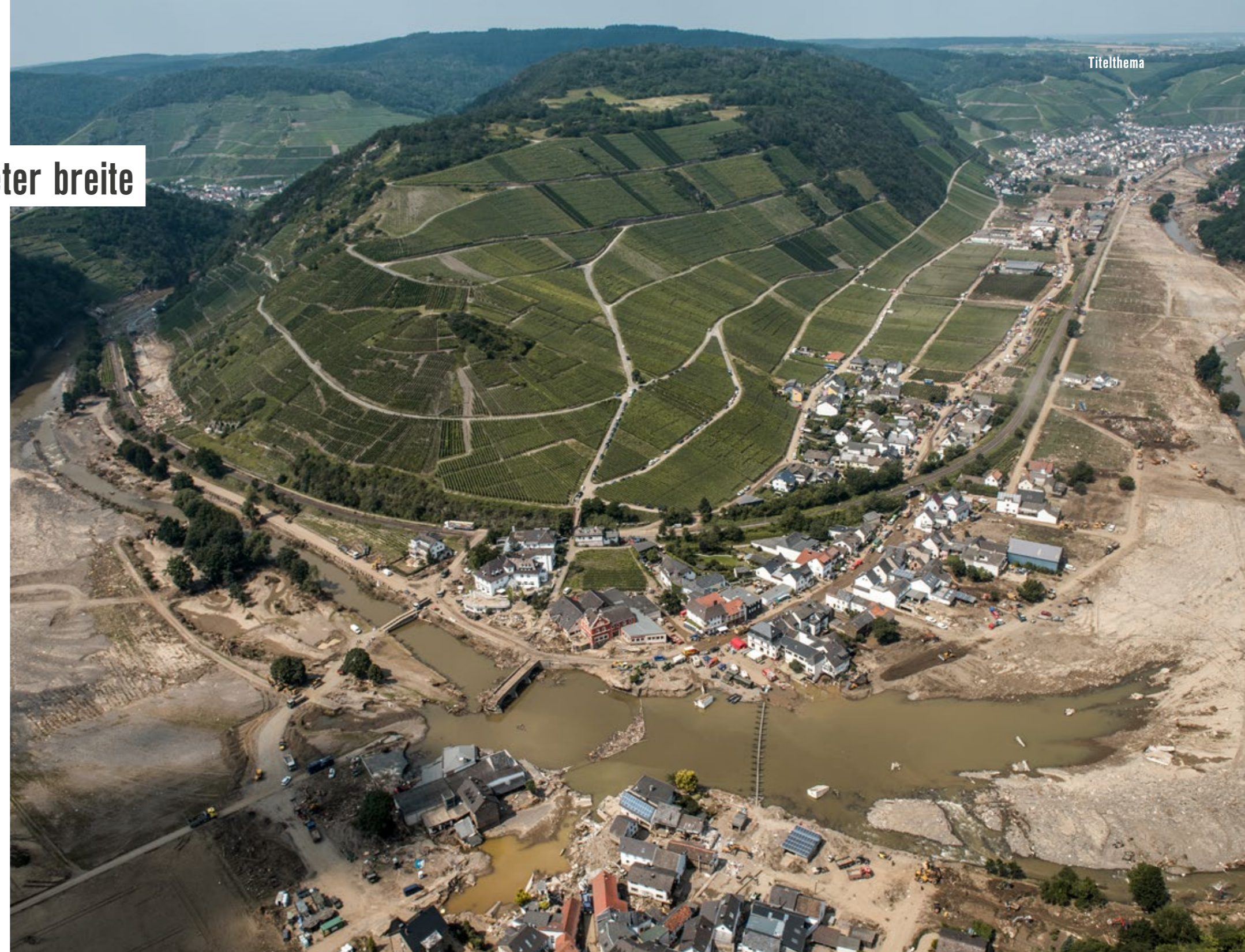
Das Wasser geht, die Zerstörung bleibt.
