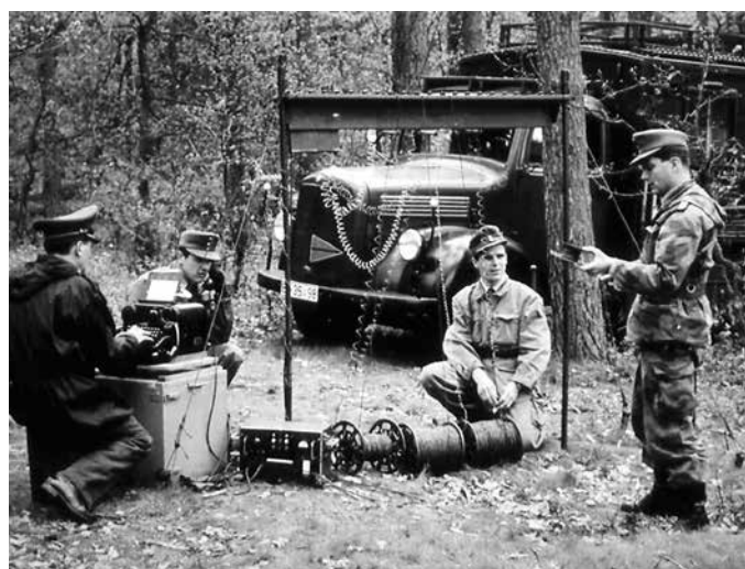
Feldkabelbau im Gelände
