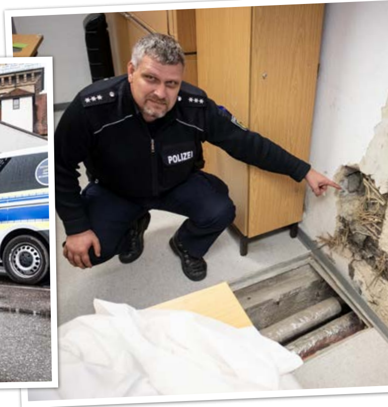
Thorsten Kniehl zeigt die Stelle, an der die marode Bausubstanz offensichtlich wird.
