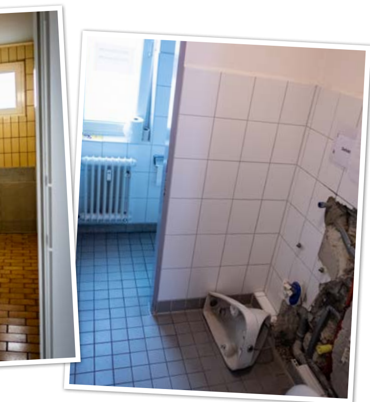
Aufgrund eines Wasserschadens waren die Toiletten nur eingeschränkt nutzbar.
